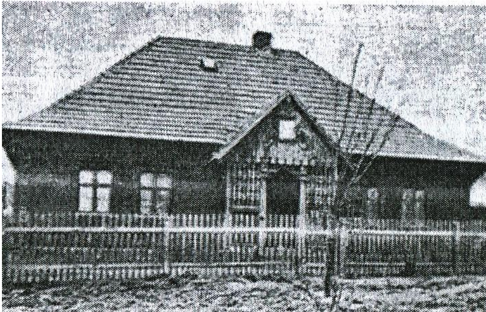
Ilustracja. Widok chałupy Branickiej w Dziekanowicach [w:] Marian Magdziak, Od chłopskiej chałupy do domu współczesnego rolnika , Politechnika Łódzka, Łódź 2020. Dobrze widoczny jest czterospadowy dach pokryty gontami (choć według mnie za wysoki jak na sołtysówkę) i wystawka-ganek dostawiona do frontowej elewacji.
